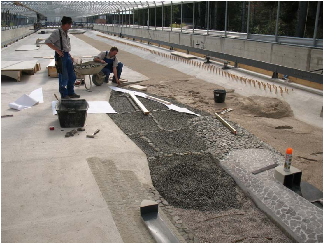
Neuer Einlaufbereich der großen in die kleine Isar
