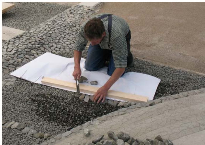
Stein für Stein wird die neue Rampenstruktur gesetzt
